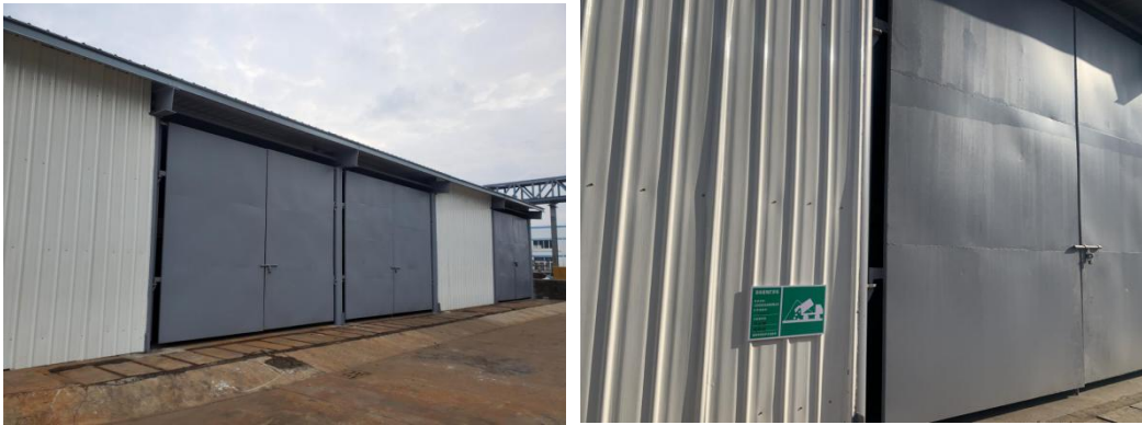
图 4-14 项目一般固废仓库外部现状图
