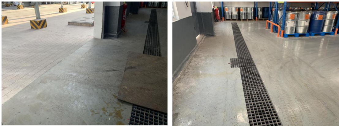
图 4-25 项目门口高坡和导流槽（导流槽相对于两侧地面较低）
