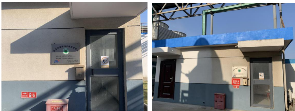
图 4-38 废气在线监测装置现场图片
