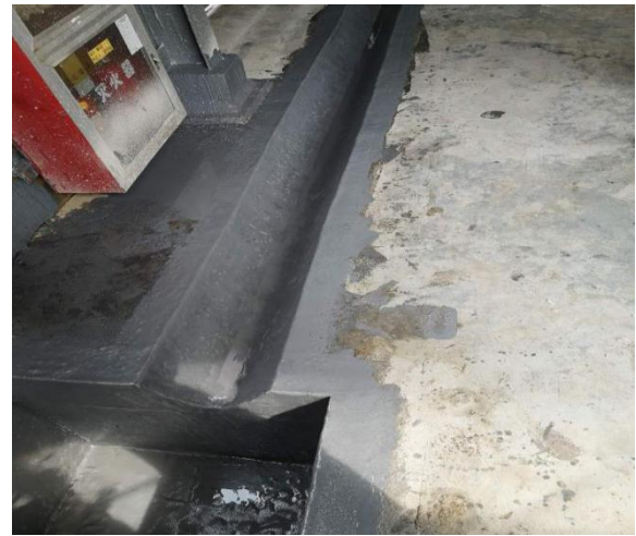
固废库均存在的导流沟、收集池
